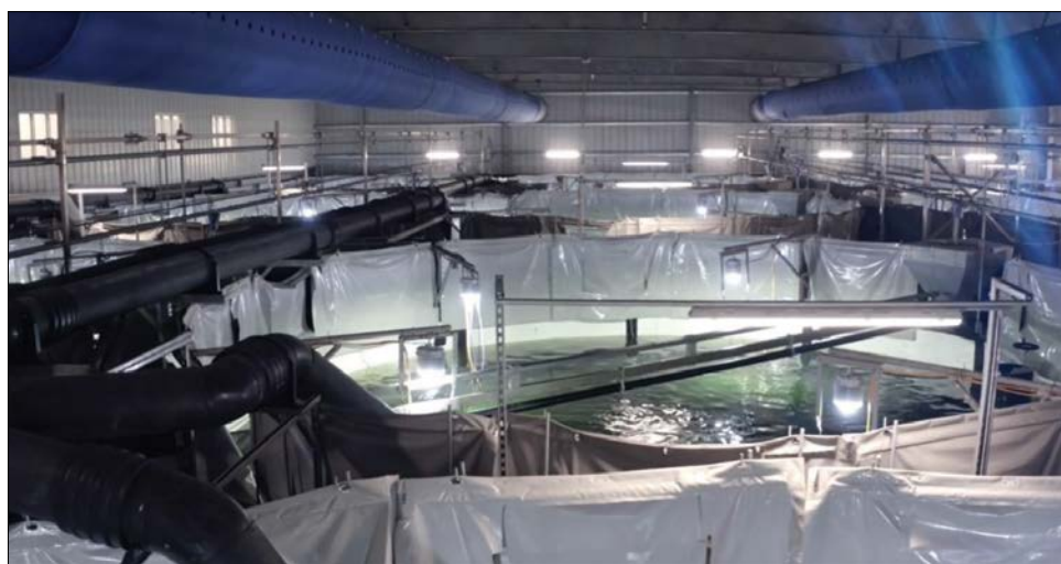
2. ábra: Az Atlantic Sapphire projekt keretében Floridában épülő szárazföldi lazac termelő rendszer első RAS telepe (Forrás: Atlantic Sapphire)
